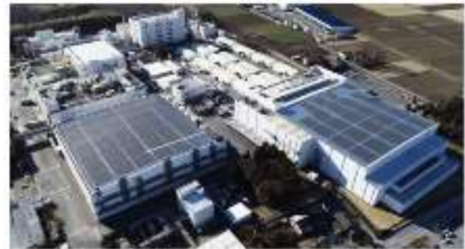
図1 栃木工場の太陽光発電設備(生産棟の屋上の様子)
