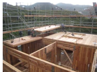
CLTを用いた施工例
