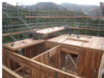
CLTを用いた施工例
