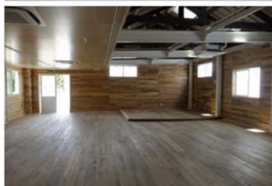
ゴーリキアイランド新社屋建築工事 (三重県)
