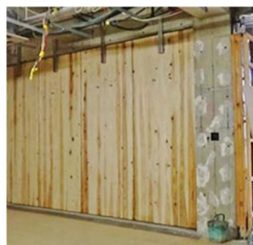
木質耐震壁接着工法 (竹中工務店)
