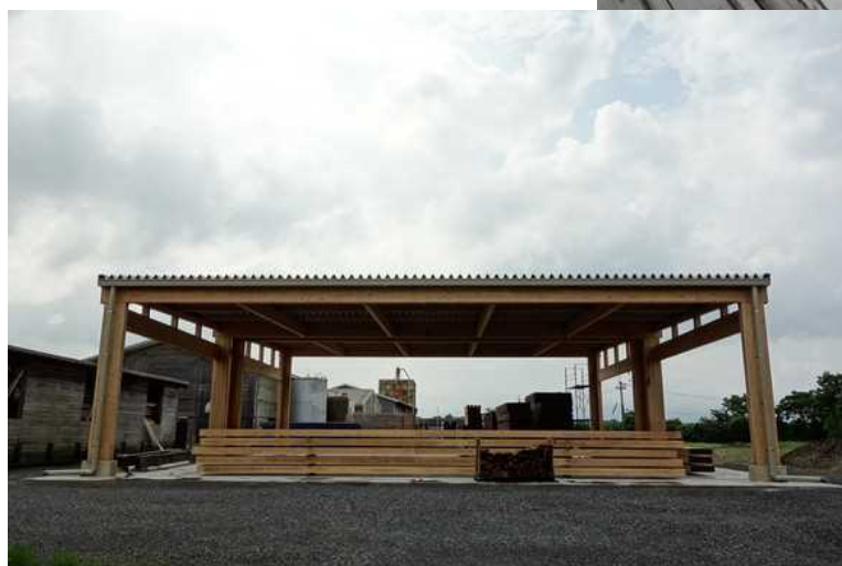
SAMURAI I集成材試作棟 間口18m × 奥行20m たわみ 中央部で4mm
