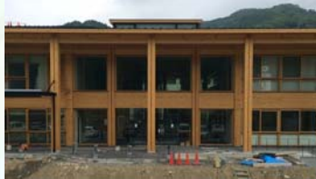
落合総合センター (平成28年4月開所)
