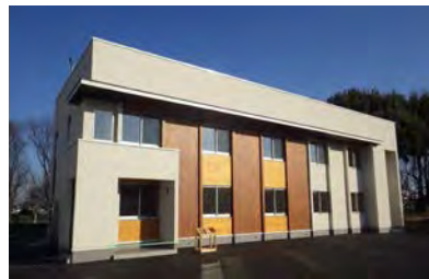
三井ホームコンポーネント(株)事務所【埼玉県】
