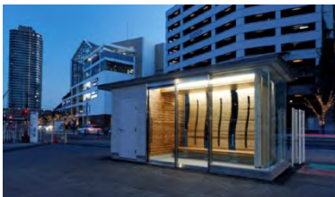
ハーバーランドバス駐車場CLT休憩所【兵庫県】
