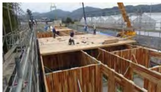
パネル工法の施工
