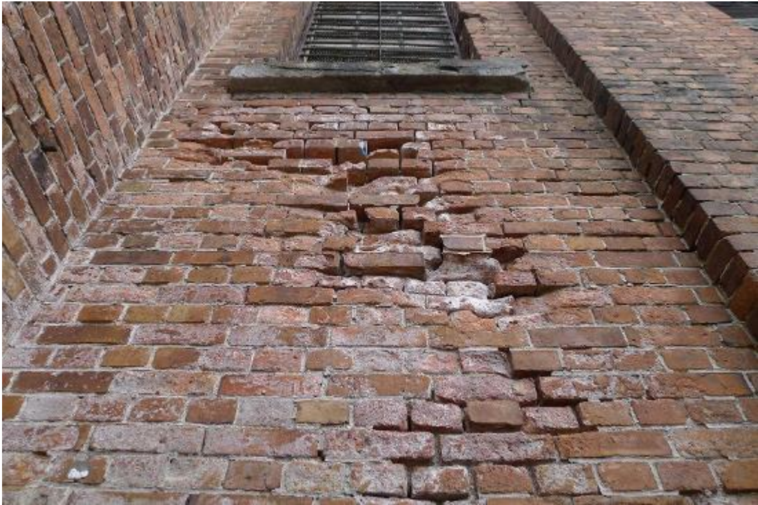
煉瓦補修 このように深く劣化してなくなった部分に補足煉瓦を張り込む
