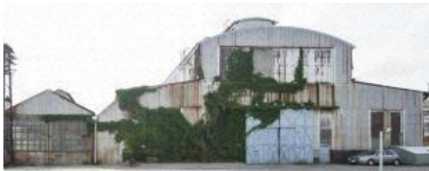
修繕工場（西面外観）
