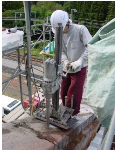
鉄筋挿入穴穿孔 (42φ, 3.8~7.0m)
