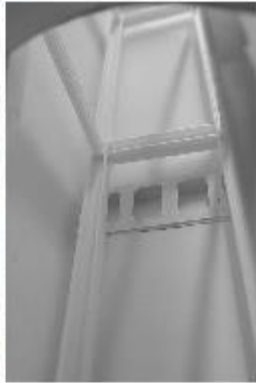
⑥b 排気塔フレーム補強を排気塔直下より見上げる
