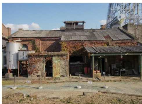
図5 安全燈室及び浴室
