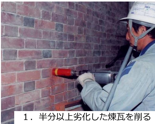
煉瓦補修 このように深く劣化してなくなった部分に補足煉瓦を張り込む
