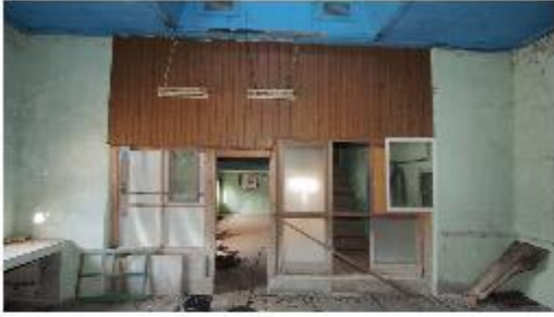
◎X4 通りフレーム補強を浴室より見る
