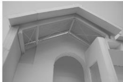
①倉庫1（旧扇風機室）脇間の屋根構面補強を棟間通路より見上げる
