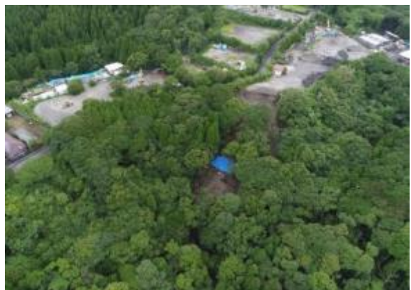
写真2 被災状況(遠景)(2019.7.1撮影)
