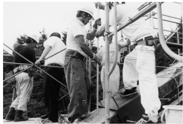
鉄筋挿入 (煉瓦厚 333mm, 1-D22)
