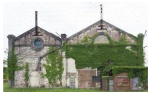
遠賀川水源地ポンプ室（西面外観）
