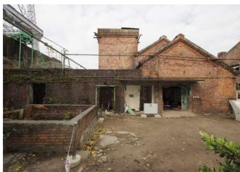
図4 倉庫及びポンプ室
