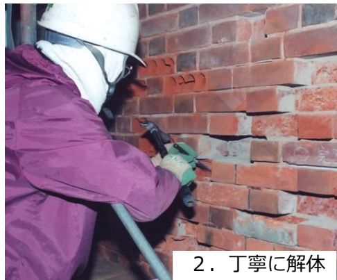
煉瓦補修 このように深く劣化してなくなった部分に補足煉瓦を張り込む
