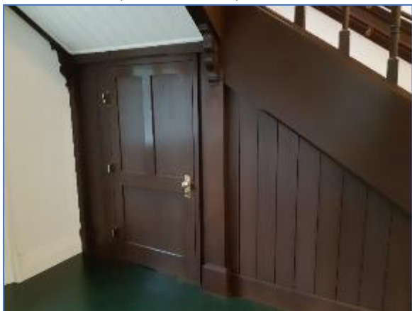
1 階階段室(階段下倉庫)
