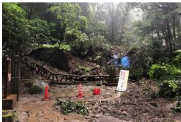
写真3 被災状況(炭窯)(2019.7.1撮影)
