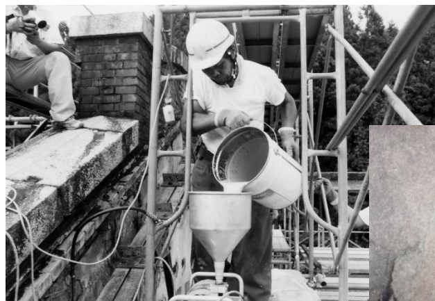
セメントスラリー注入
