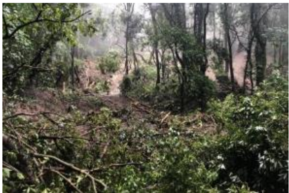
写真4 被災状況(斜面地)(2019.7.1撮影)
