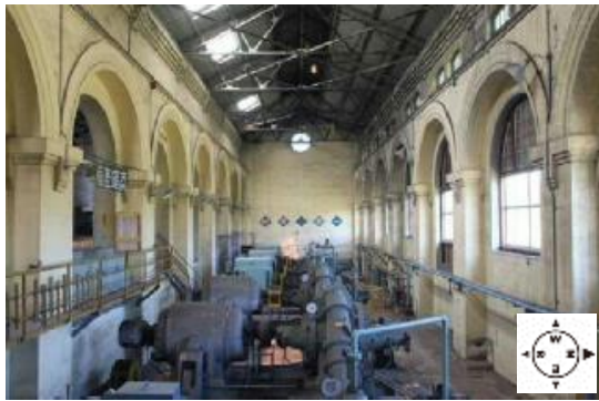
①現況写真〔東→西〕
