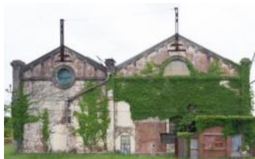
遠賀川水源地ポンプ室（西面外観）
