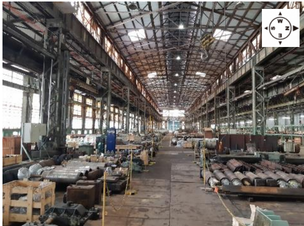
①現況写真〔東→西〕
