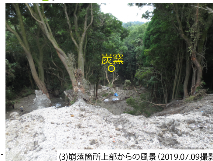
(2)崩落箇所上部2(2019.07.09撮影)
