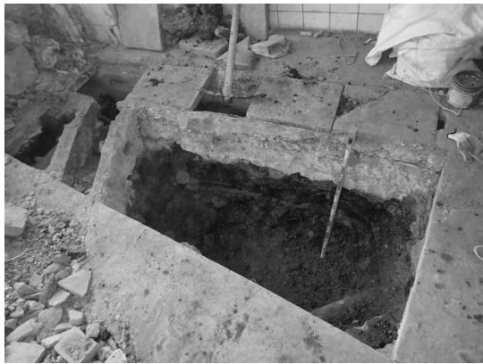
写真 2-4-93 試掘箇所②完掘 南から
