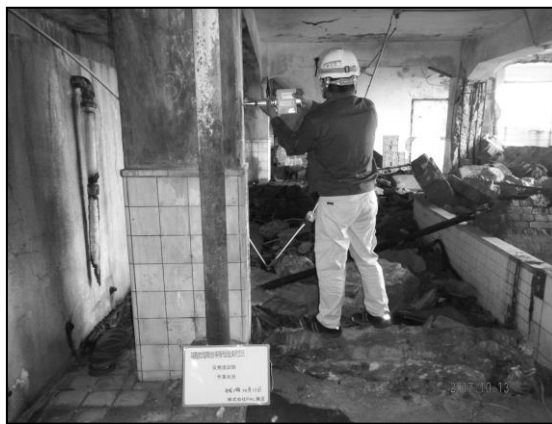
写真 2-4-71 反発度試験状況
