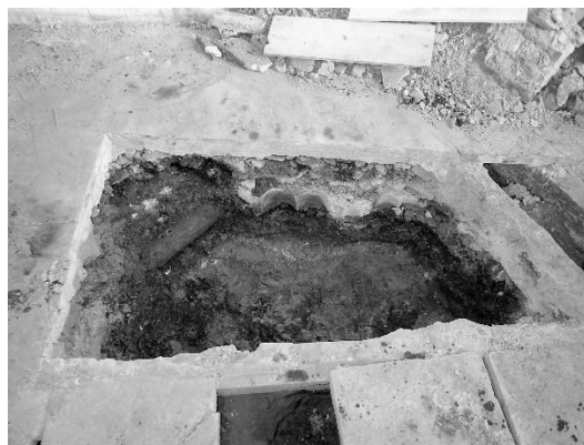
写真 2-4-92 試掘箇所②2層面・土管
