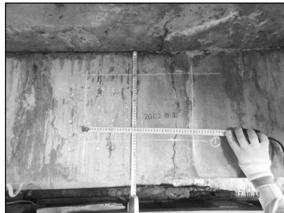
配筋状況 (2G02 側面)
