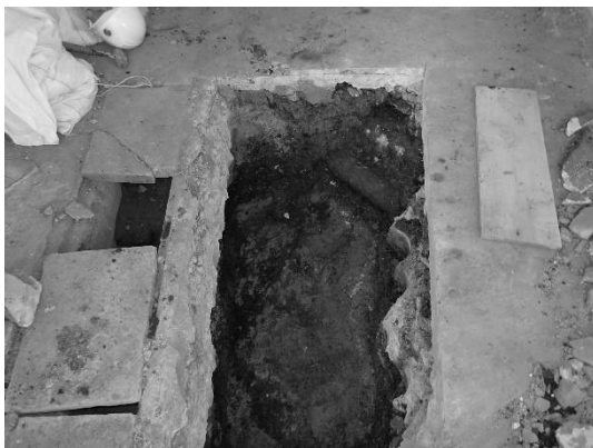
写真 2-4-78 試掘箇所②調査状況
