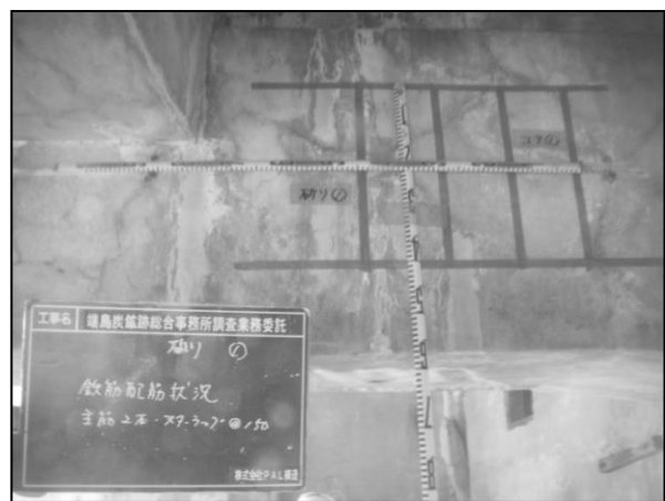
鉄筋配筋状況
