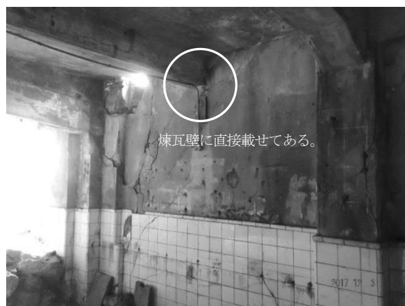
写真 2-4-106 小梁 B5 と煉瓦壁の接合状況
