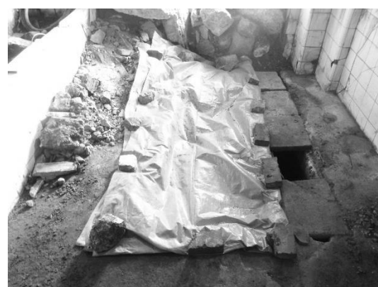
写真 2-4-81 試掘箇所②埋戻し完了
