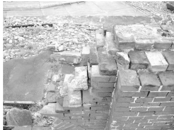
写真 2-4-109 煉瓦壁西側の状況
