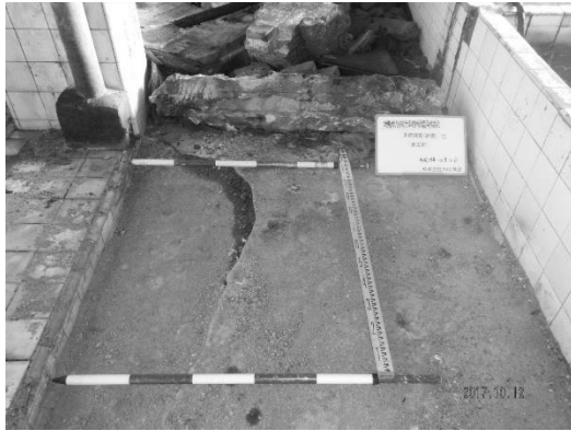
写真 2-4-74 試掘箇所①着工前
