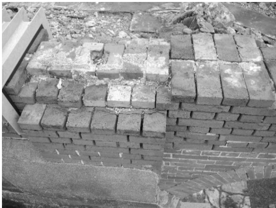
写真 2-4-108 煉瓦壁天端の状況
