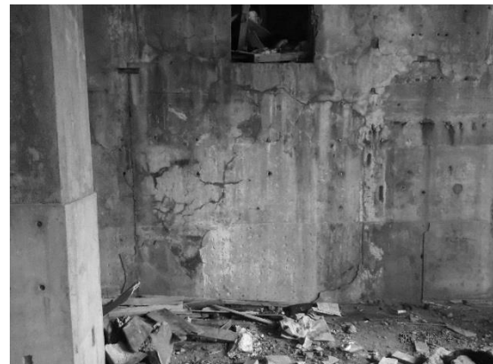
写真 2-4-96 A(北)面外壁
