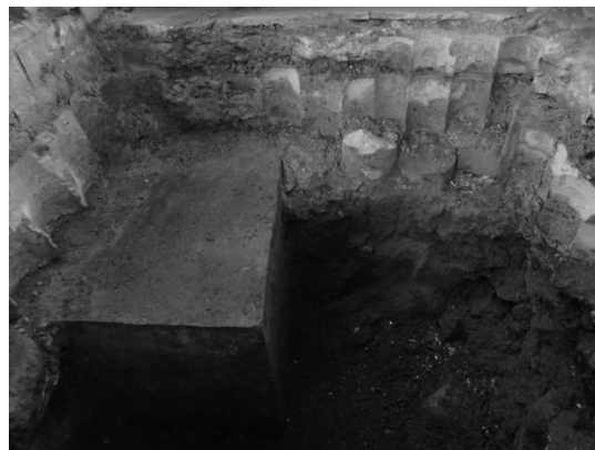
写真 2-4-83 試掘箇所① 基礎
