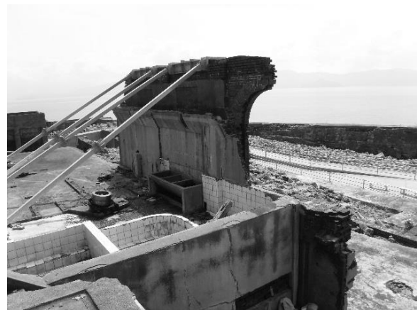
対象建物外観(西側)
