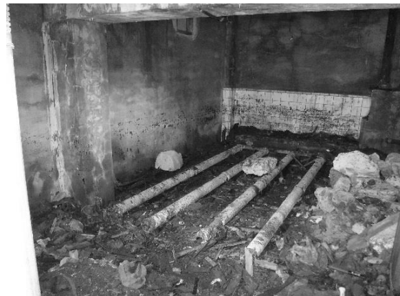
対象建物内観(倉庫)
