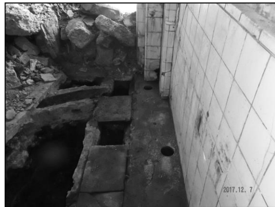
コア削孔完了後
