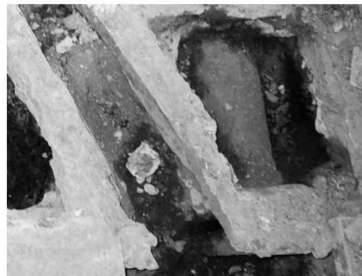
写真 2-4-90 拡大（鉄管部分）
