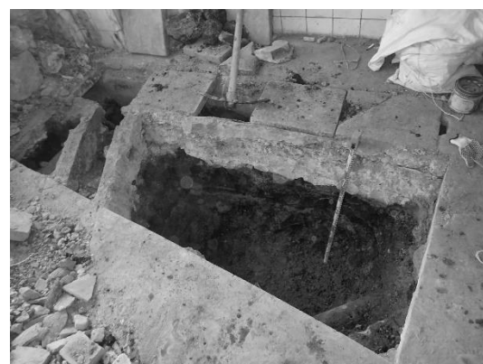
写真 2-4-79 試掘箇所②完掘状況
