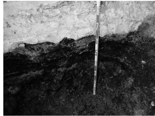
写真 2-4-87 試掘箇所②南壁
