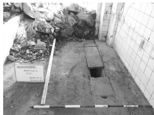
写真 2-4-77 試掘箇所②着工前
