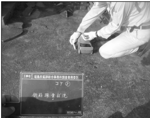
鉄筋探査(電磁波レーダー法)作業
