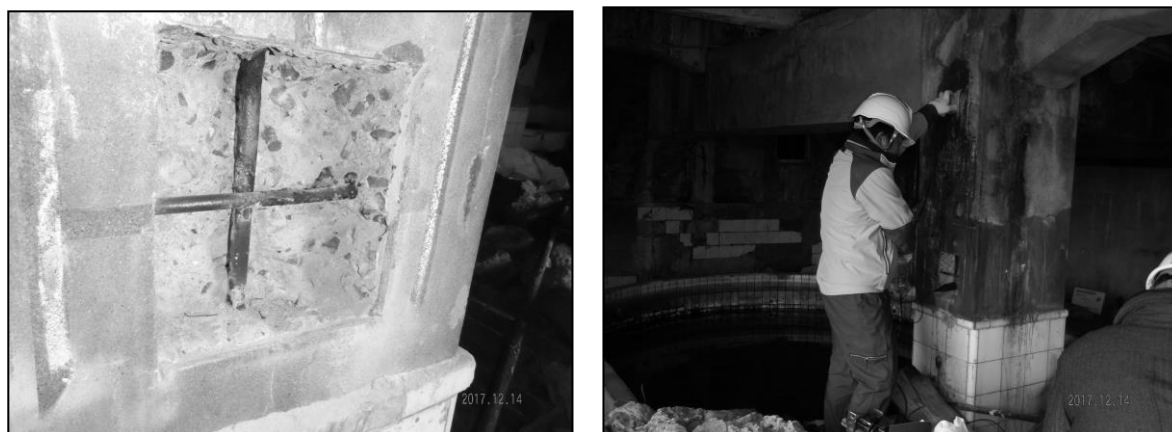
写真 2-4-72 鉄筋腐食度調査状況
