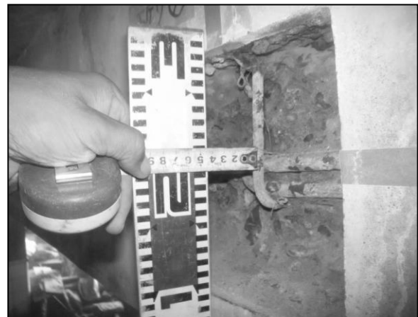
かぶり厚さ実測作業
