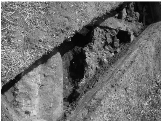
写真 2-3-99 トレンチ 5 完掘
