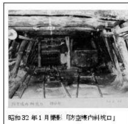
写真 2-3-59 坑口調査 2 昭和 32 年(1957)
