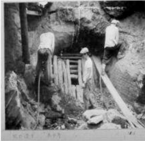
昭和 31 年 6 月撮影「坑口造り 追水跡」
