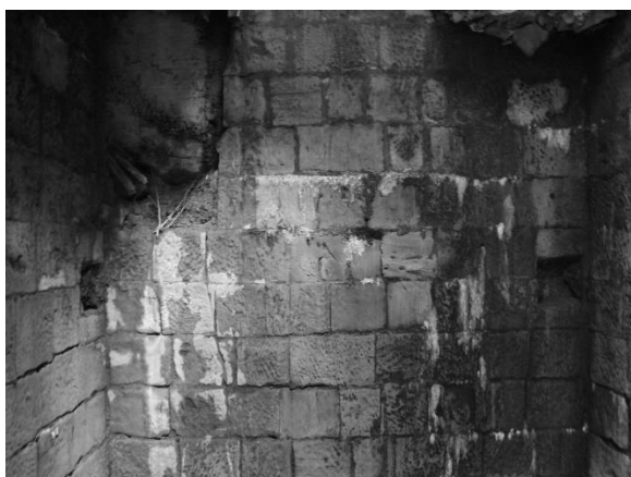
写真 2-3-87 第3 豎坑跡南壁
