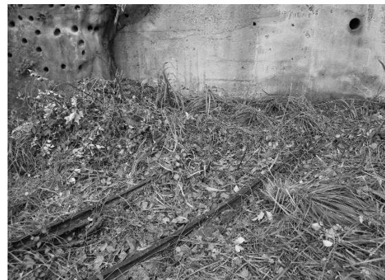
写真 2-3-57 坑口調査 2 トッコロレール
