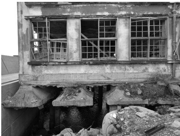
建物北側の基礎部
