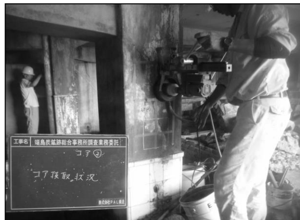
コア削孔作業
