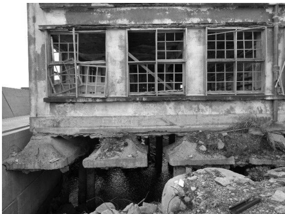
建物北側の基礎部
