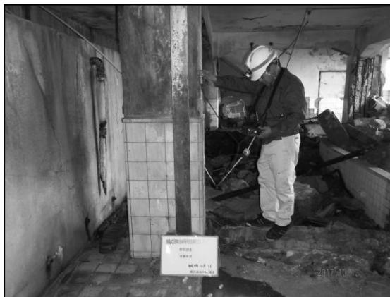
配筋調査状況
