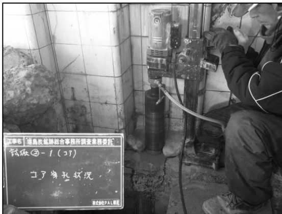
コア削孔状況
