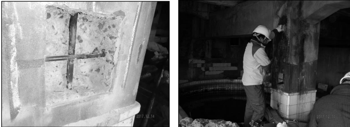
写真 2-4-72 鉄筋腐食度調査状況
