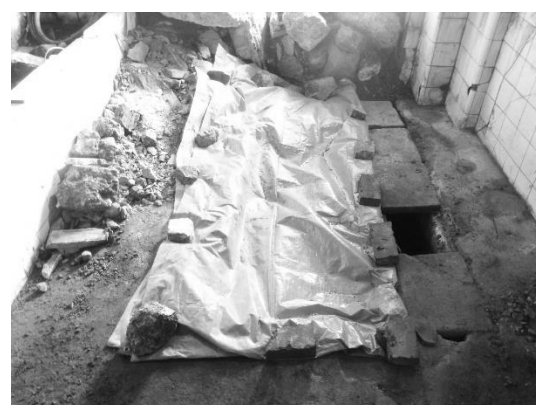
写真 2-4-81 試掘箇所②埋戻し完了
