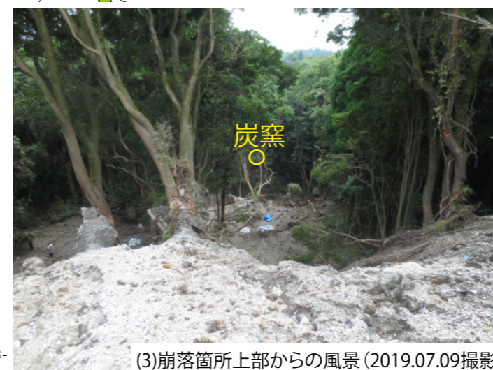
(2)崩落箇所上部2(2019.07.09撮影)
