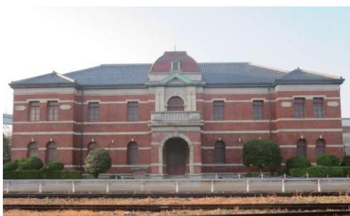
旧本事務所（北面外観）
