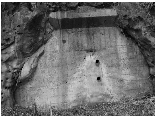
写真 2-3-56 坑口調査 2 全景
