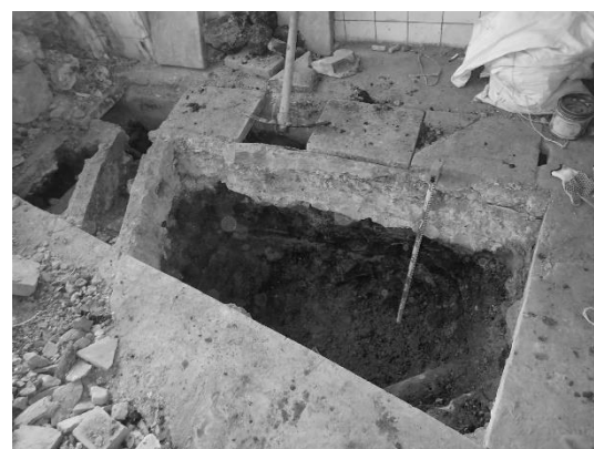
写真 2-4-79 試掘箇所②完掘状況
