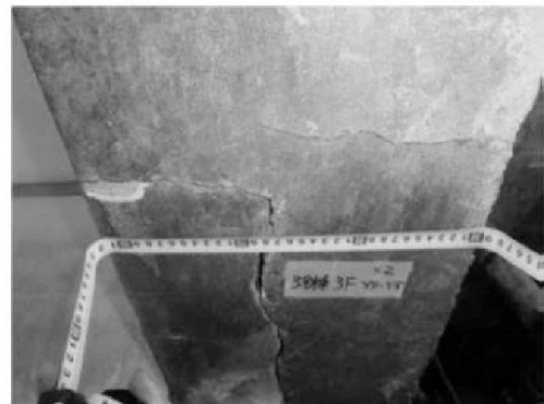
写真 2-4-123 梁寸法の計測
