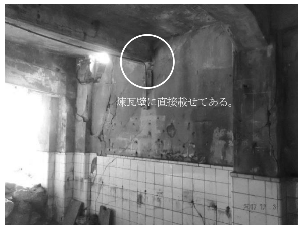
写真 2-4-106 小梁 B5 と煉瓦壁の接合状況
