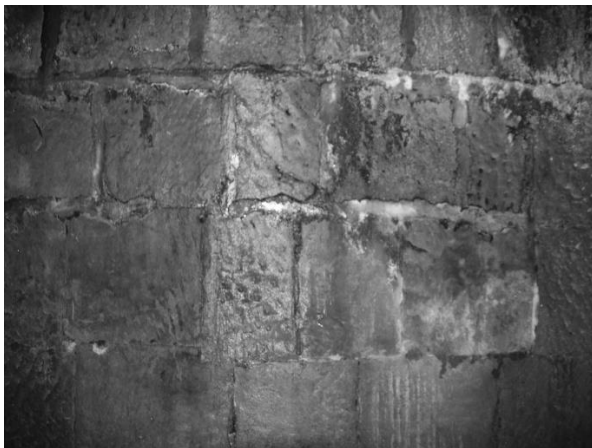
写真 2-3-85 第3 豎坑跡東壁
