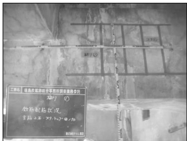
鉄筋配筋状況
