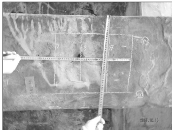
梁下面配筋状況
