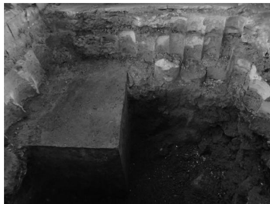
写真 2-4-83 試掘箇所① 基礎
