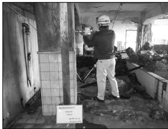
写真 2-4-71 反発度試験状況
