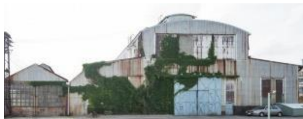
修繕工場（西面外観）
