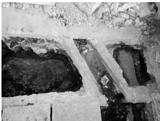
写真 2-4-89 試掘箇所②鉄管・2層確認状況 南より
