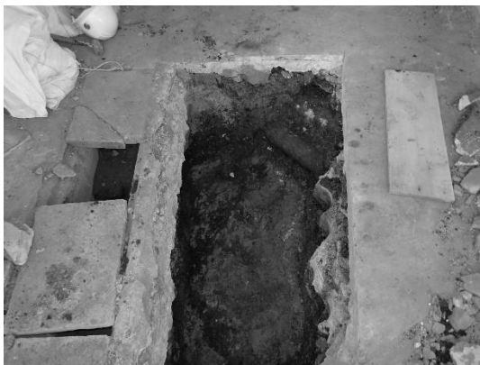
写真 2-4-78 試掘箇所②調査状況
