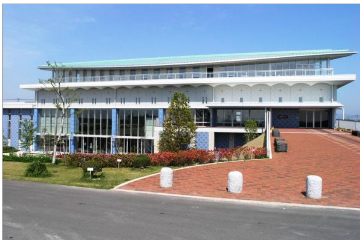
図 4 佐野常民記念館の外観（資産側から見た現状）
