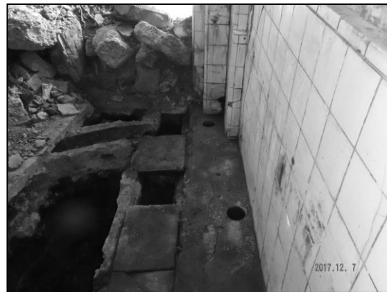
コア削孔完了後
