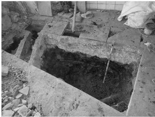
写真 2-4-93 試掘箇所②完掘 南から
