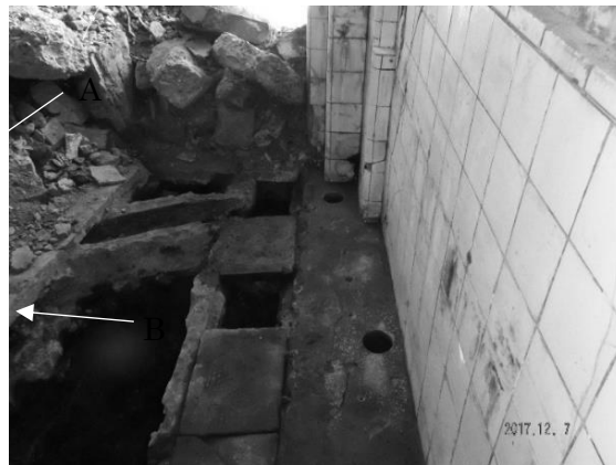
写真 2-4-104 コアボーリング箇所 A通り 3 柱
