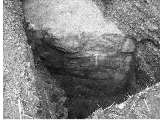
写真 2-3-94 トレンチ 2 護岸石垣
