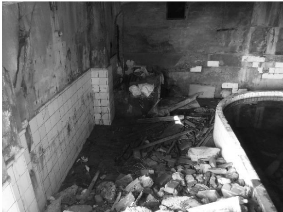
対象建物内観(浴室)
