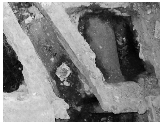
写真 2-4-90 拡大（鉄管部分）
