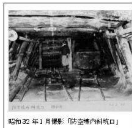
写真 2-3-59 坑口調査 2 昭和 32 年(1957)
