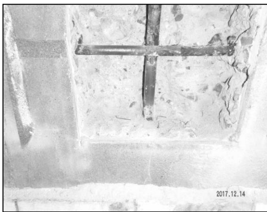
鉄筋状況（柱）
