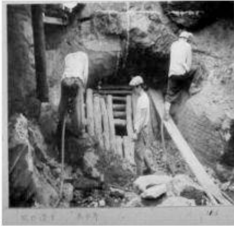
昭和31年6月撮影「坑口造り 追水跡」
