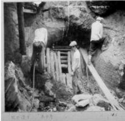
昭和31年6月撮影「坑口造り 追水脚」
