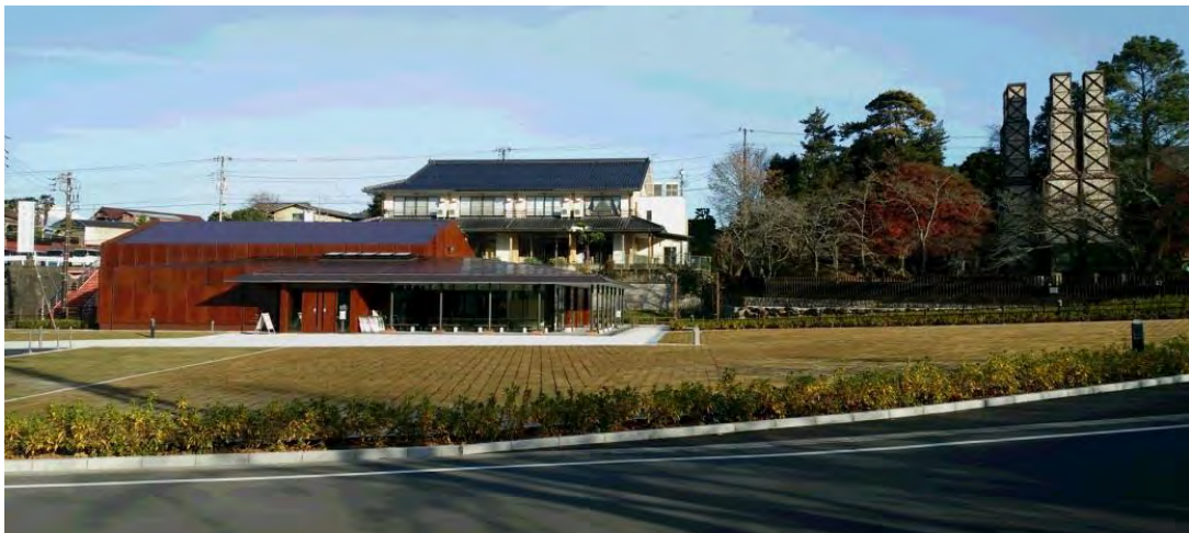
新築後写真(平成28年(2016)12月撮影)
