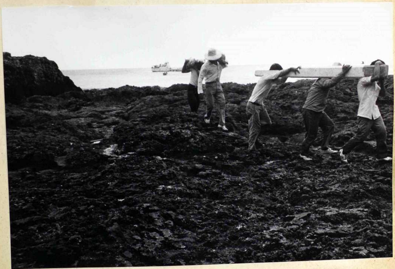
島嶼標設置作業 (南小島) 左も同。
