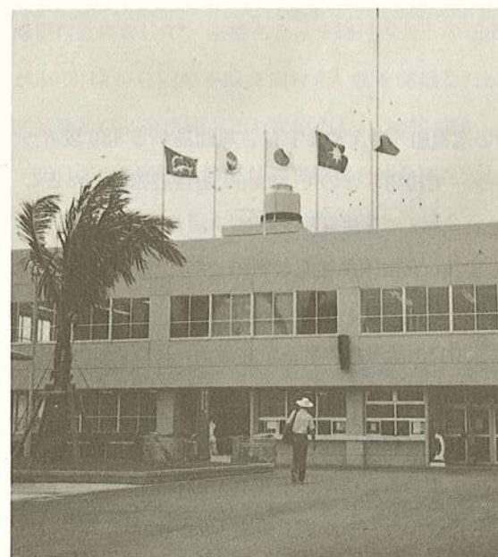
警備救難隊の庁舎となったポートセンター
