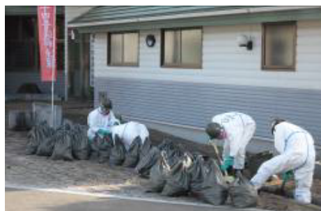
飯館村役場における側溝の汚泥除去
