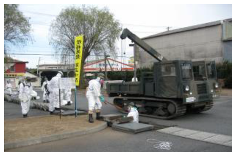
浪江町役場における側溝の汚泥除去
